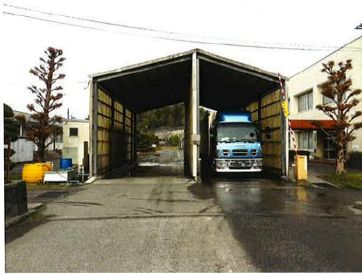
消毒槽(工場を出入りする車両を消毒)
