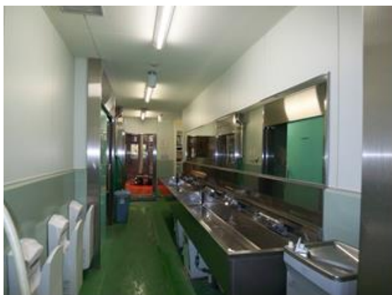
牛解体室サニタリー
