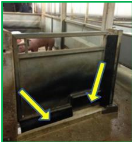
オランダのWestfort社の豚のと場のすき間風を防ぐゴム製カーテンの良い例（写真左）。すき間風の原因となる開口部（写真右）。
