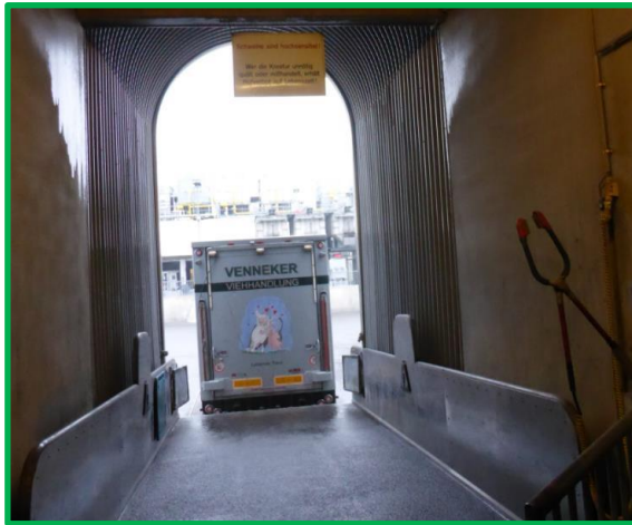
積み下ろし場のスロープの側面は高く頑丈にする。
