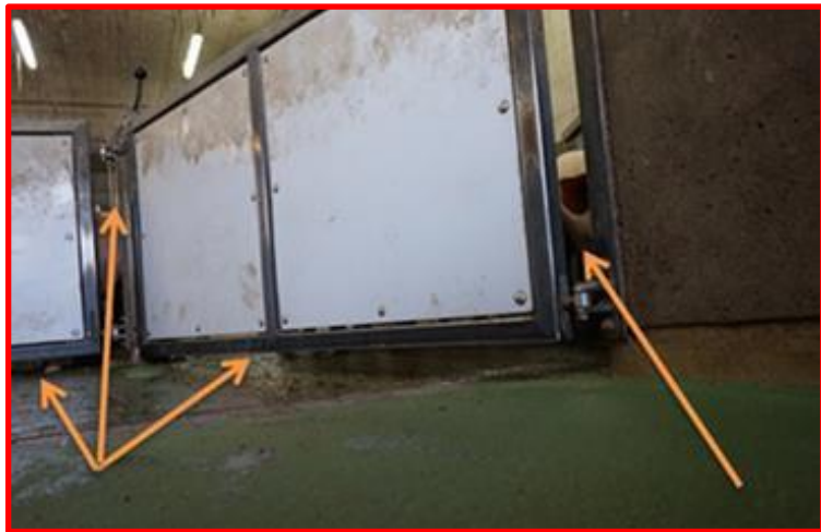
オランダのWestfort社の豚のと場のすき間風を防ぐゴム製カーテンの良い例（写真左）。すき間風の原因となる開口部（写真右）。
