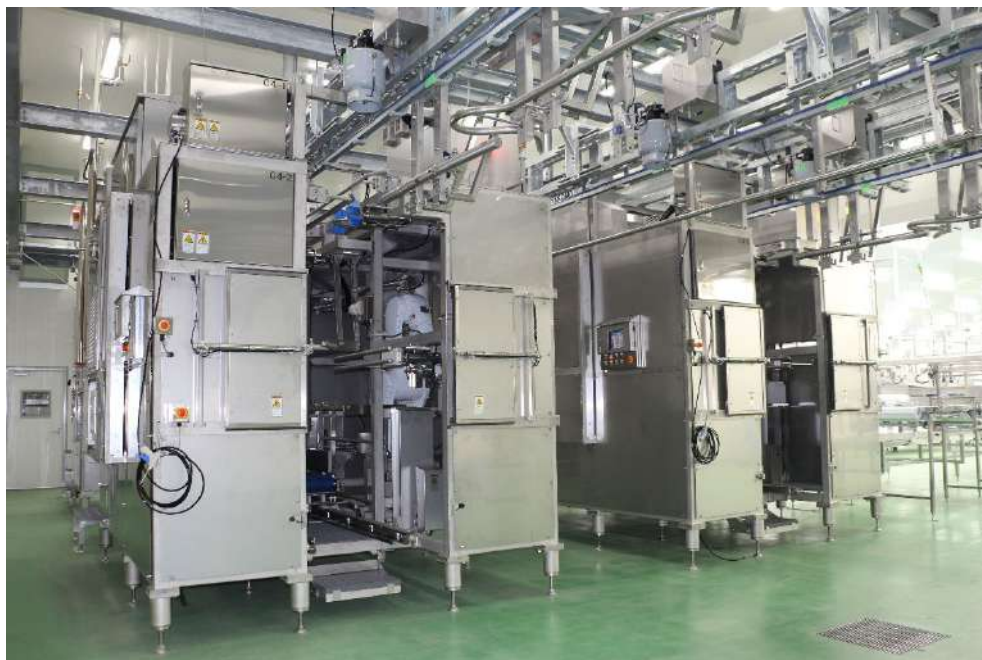
図 1 0 導入された大分割装置 2ST タイプ設置時の様子
