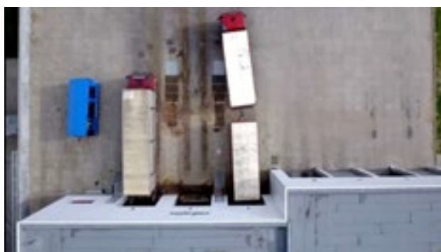
写真3 荷下ろし場(俯瞰)
