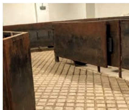
床の滑り止め構造の変化(場所によって異なる)
