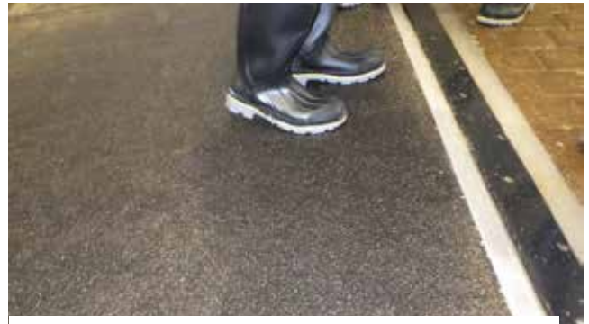
写真3 スロープの滑り止め加工
