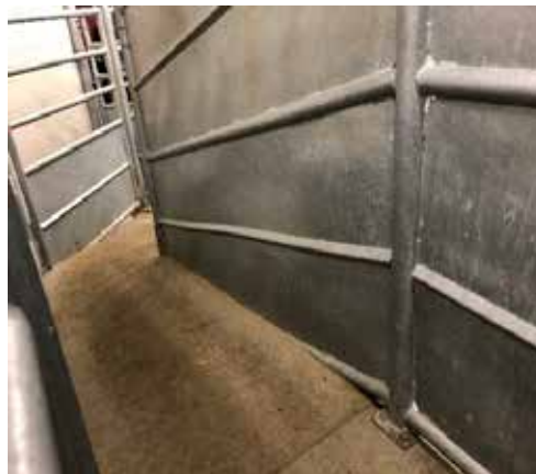
②誘導路 両側方は目隠し
