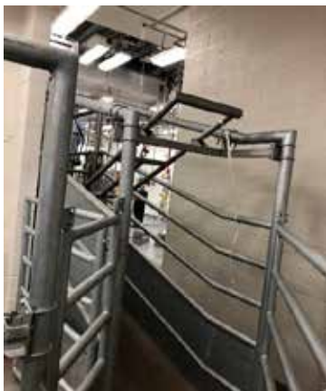
①係留所から誘導路 上り傾斜になっている
